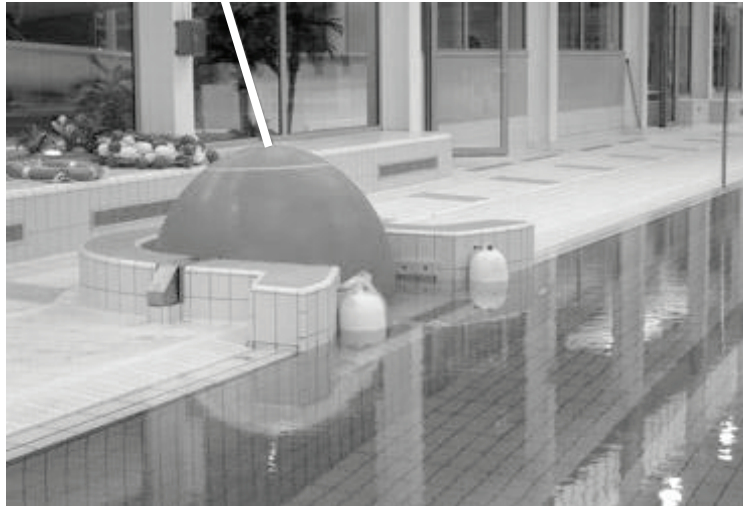
Figure 4 - Boule à vagues en attente avant sa mise en position dans le bassin
